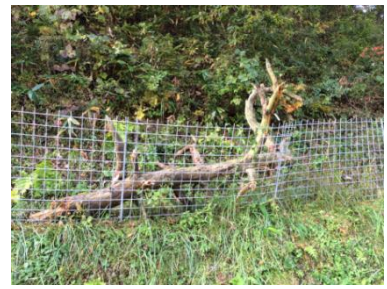
倒木で破損した侵入防止柵
