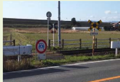
第 4 種踏切道（北松江線）
