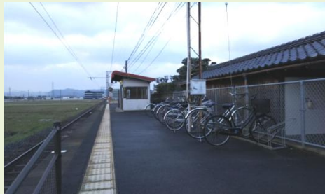
上屋のない駐輪場（武志駅）
