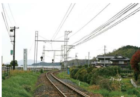
レールを使用した架線柱
