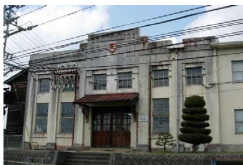
一畑電車布崎変電所
