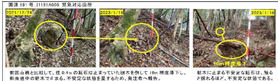
写真 1 緊急対策が必要な箇所の報告例
