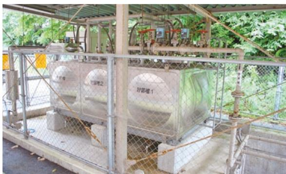
図4 排水処理装置
