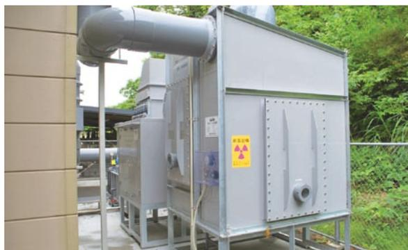
図3 排ガス処理装置
