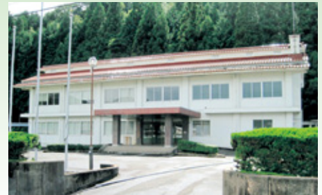
飯南寮(いinanりょう) 飯南校から約3kmの地点にある学生寮 (男女)です。部屋は一人一室です。
